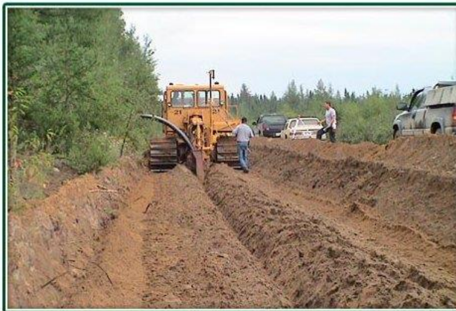
INSTALLATION TUYAU FUSIONNÉ - LAC ST-JEAN - DRAINAGE BELLE-TERRE INC. / DRAINAGE LAZURE INC.
